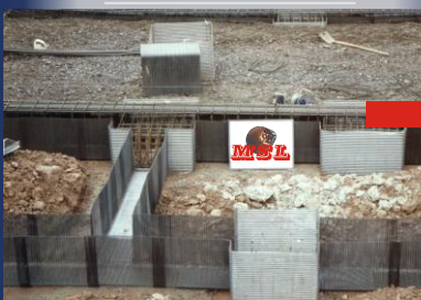
FS-U-Form wellprofilerte Balkenschalung FSL-U-Form wellprofilerte Lochblechschalung
